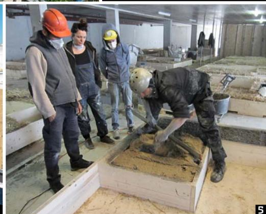
posteur à copeaux où des milliers de lombrics assureront le travail d'épuration. Elles transiteront encore, avec les eaux grises, par des filtres minéraux avant de rejoindre une citerne. De là l'eau épurée sera réinjectée dans le circuit et pourra être réutilisée pour l'arrosage, la lessive et les WC.
